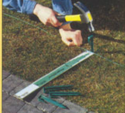
Die Installation des Begrenzungsdrahtes.
